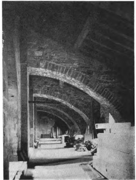
Durham Nave Triforium.
